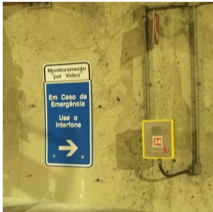
Figura 16: Nova placa instalada nas laterais dos recuos, ao lado do interfone. Fonte: imagens fornecidas pela equipe NudgeRio
