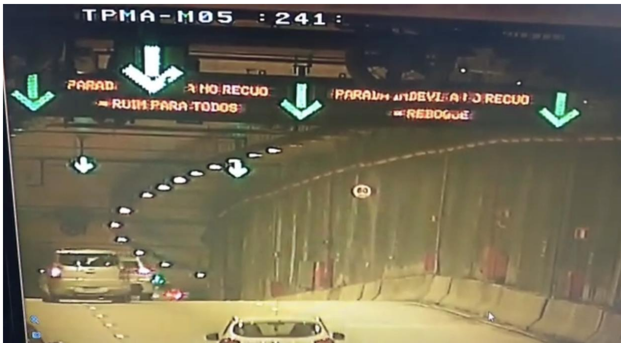
Figura 17: Imagens das câmeras de segurança dos túneis com as novas mensagens do PMV em funcionamento. Fonte: Imagens fornecidas pelo CCO
